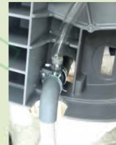
[Anschluss des Ablaufschlauchs]
