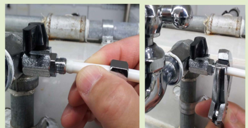
[Anschluss des Einlassschlauchs]
