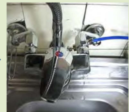
[Anschluss des Einlassschlauchs]
